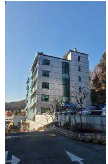
▲ 전경(측면):1층 출입구 방면
