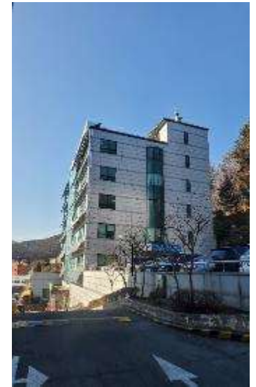
▲ 전경(측면):1층 출입구 방면
