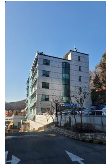
▲ 전경(측면):1층 출입구 방면
